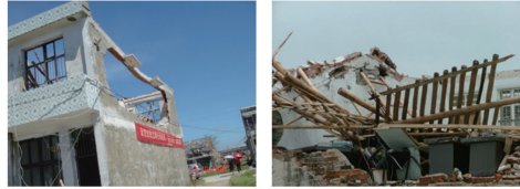
掀翻屋盖、破坏墙体、造成局部倒塌
